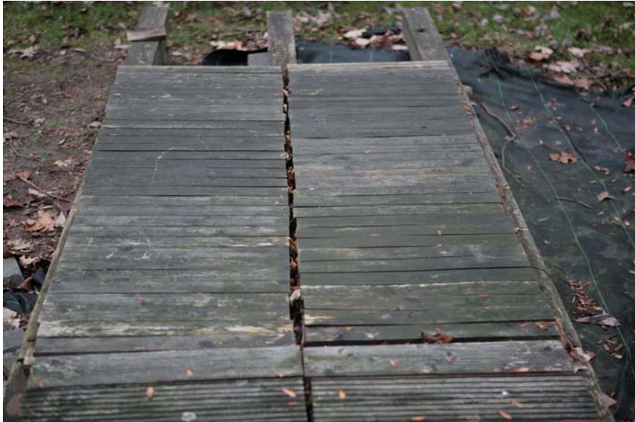
Abbildung 30: Oberlage der Laborplatten nach 24-monatiger Freibewitterung
