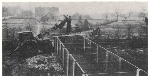
Bild 1: Beschicken des ebenerdigen Silos mit dem Frontlader.
