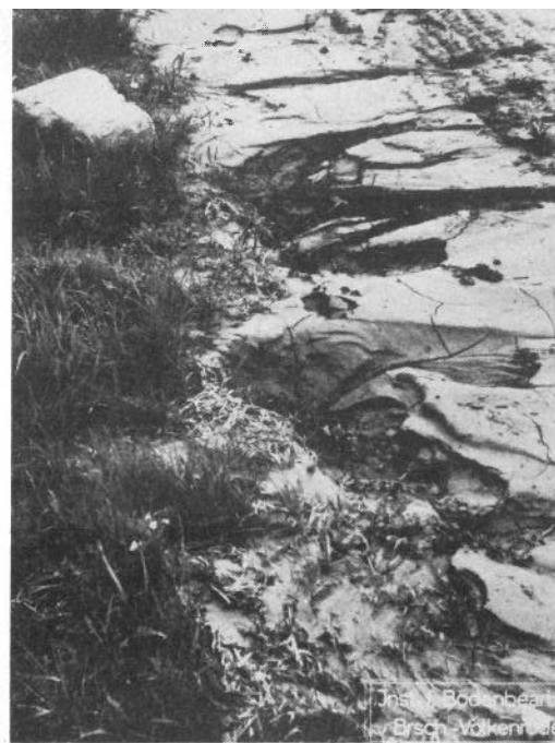
Abb. 7: — und füllt und verstopft Gräben und Abflüsse. Dia 72/52
