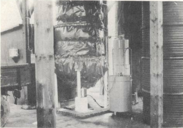
Bild 1: Blick auf Behälter und Meßhaus.
