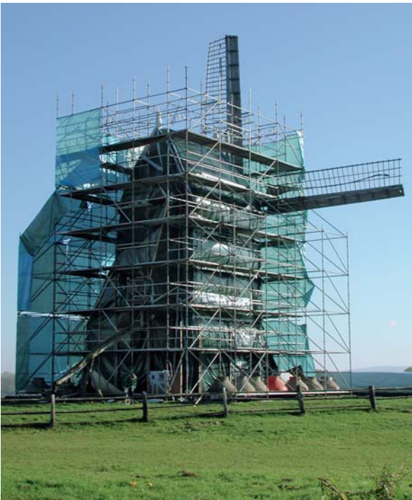
Abb. 6: Behandlung einer Mühle im Westfälischen Freilichtmuseum Detmold
