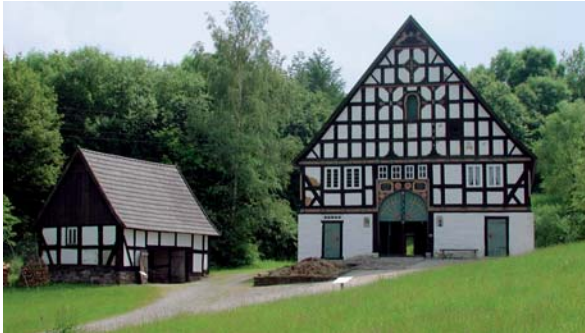
Abb. 1: Im Westfälischen Freilichtmuseum in Detmold werden seit 1999 Monitoringmaßnahmen durchgeführt.
