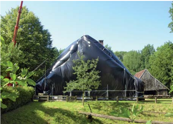
Abb. 4: Bekämpfung durch feuchte-geregeltes Heißluftverfahren bei einem kompletten Haus im Westfälischen Freilichtmuseum Detmold
