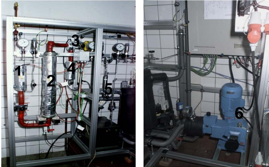
Abbildung 17 Fotos der installierten CO<sub>2</sub>-Extraktionsanlage. 1: Vorheizer; 2: Extraktor; 3: Druckregulierventil; 4: 1. Abscheider; 5: 2. Abscheider; 6: Hochdruckpumpe
