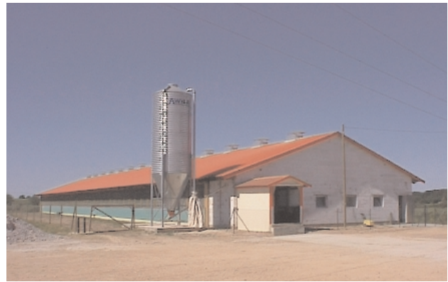
Abb. 12: Außenansicht eines Mastschweinebestandes mit freier Lüftung
