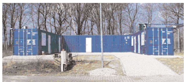
Abb. 24: BSZ-Pilotanlage an der FAL-Biogasanlage
