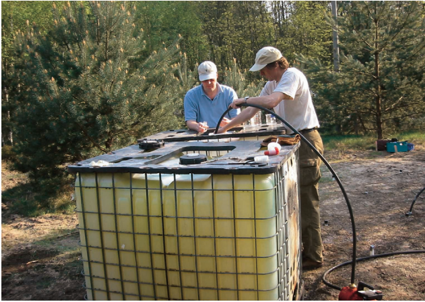
Abb. 3: Infiltration von Nährstoffen zur Stimulierung des Schadstoff-Abbaus (Dechlorierung) der natürlich vorkommenden Bakterien in einem, mit chlorierten Kohlenwasserstoffen kontaminierten Grundwasserleiter - Infiltration of nutrients for stimulating the intrinsic dechlorination activities of bacteria in an aquifer contaminated with chlorinated hydrocarbons
