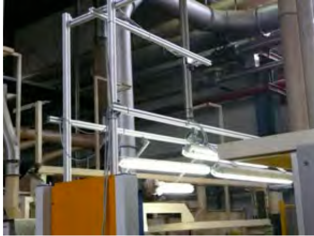
Abbildung 6-3: Versuchsaufbau 2: Die Lampen beleuchten die Matte jetzt diagonal von den Seiten. Reflektionen und Schattenbildungen durch aus der Mattenoberfläche hoch stehende Faserstrukturen werden minimiert (Grecon).
