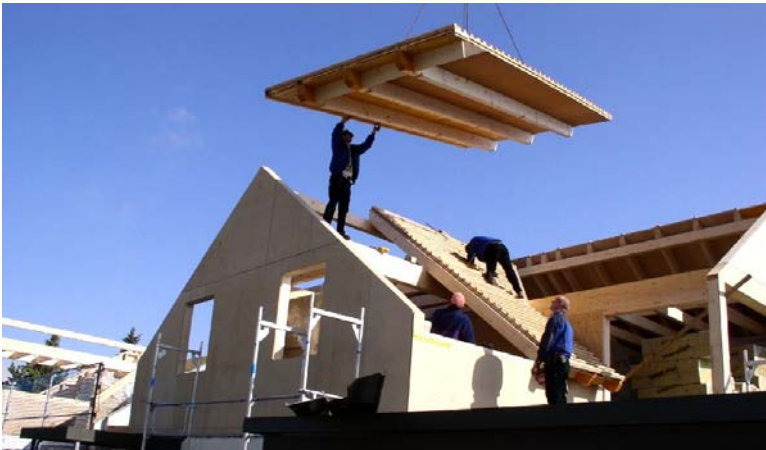
Abbildung 2.3: Dachaufstockung
