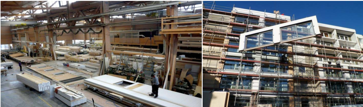
Abbildung 2.3: Vorfertigung von Holzrahmenbauelementen mit kompletter Bekleidung - Montage der Fassadenelemente
