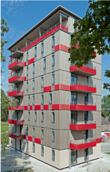
Abbildung 6.1: Mehrgeschossbau „Holz 8“, City of Wood, Bad Aibling
