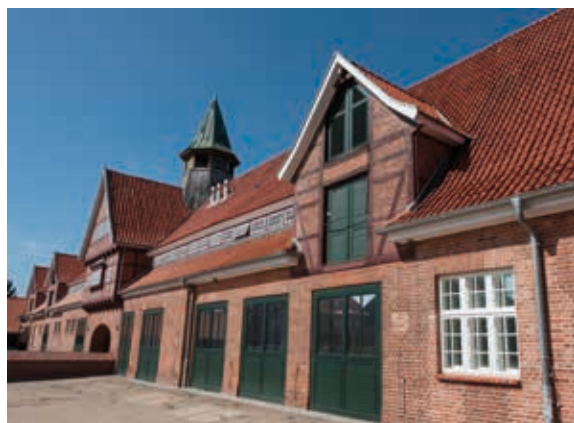
Das Karree während der Sanierung, 2015
