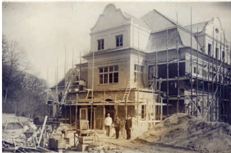
Umbau des Herrenhauses Trenthorst, um 1919
