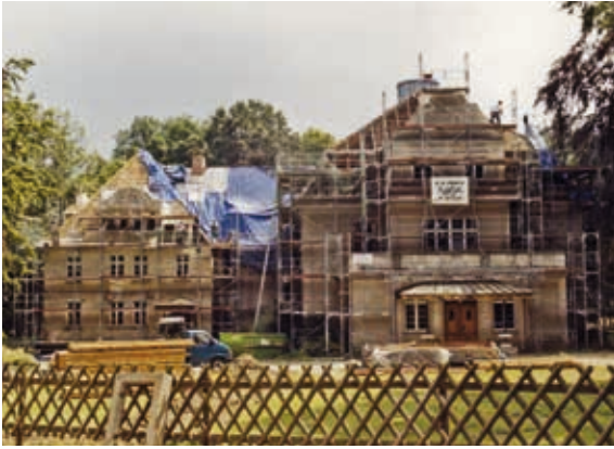
Renovierung des Herrenhauses Trenthorst, 2001
