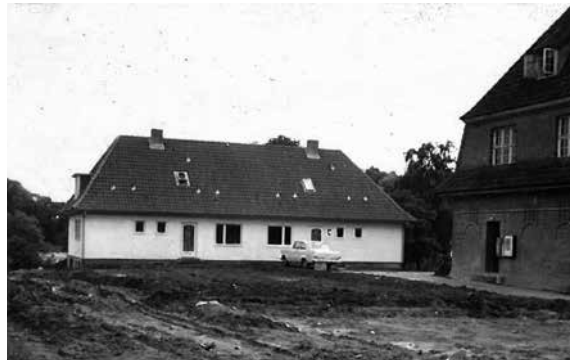
Neues Doppelwohnhaus für Dr. Andreae und Dr. Teute (später Wohnhaus Dr. Schlichting, Prof. Unshelm), rechts Haus 1, 1962
