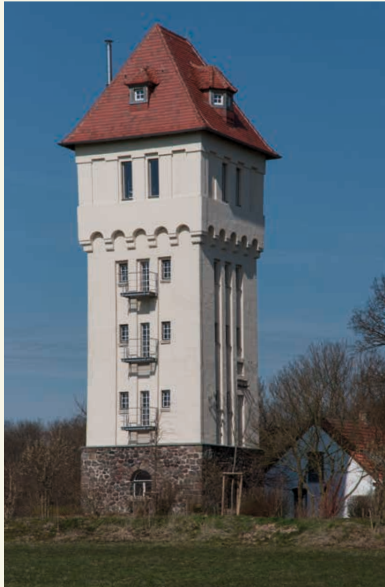
Der Wasserturm auf der Zentrale nach seiner Renovierung, 2015
