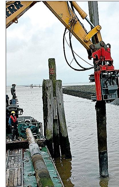
Abbildung 3 Entnahme eines geotextilgeschützten Pfahls mit Kantholzzuschnitt im oberen Bereich in Bensersiel.
