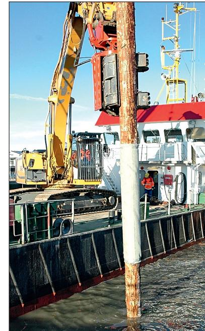
Abbildung 2 Rammung eines mit Geotextil geschützten Pfahls mit einer Vibrationsramme in Harlesiel.
