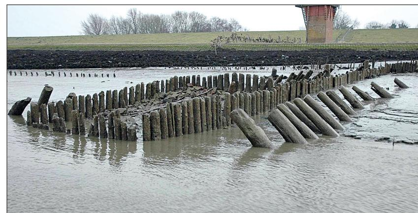
Abbildung 4 Ein Jahrhunderte altes Höft in der Ems ist nun durch die Holzbohrmuschel gefährdet, da der erhöhte Salzgehalt das Überleben der Schädlinge hier ermöglicht.
