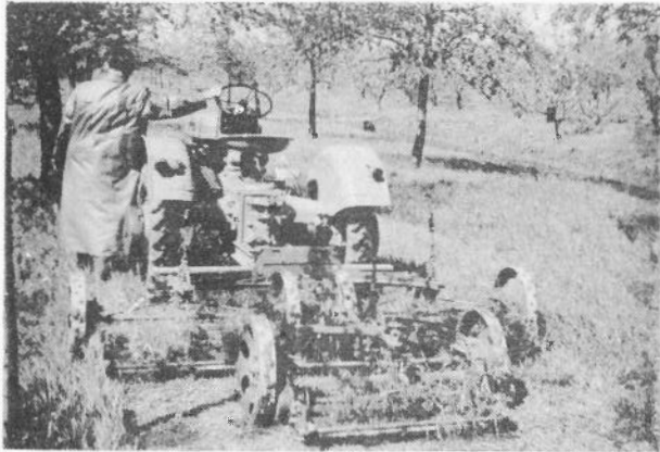
Abb. 5 Dia 89/51 Dreiteiliger Walzenmäher der Firma Ransomes, Sims & Jefferies, Ipswich.
