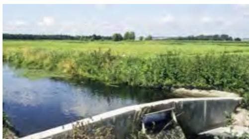
Abb. 1: Stauanlage an einem Entwässerungskanal © Dr. Ulrich Mäck, ARGE Donaumoos
