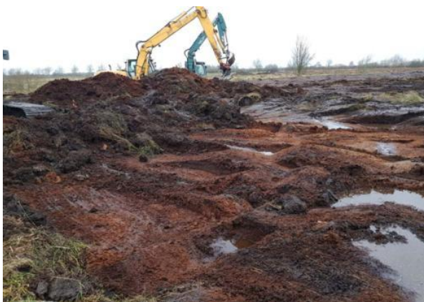
Fotos A6 und A7: linkes Foto: Aufsetzen eines neuen Walls, rechtes Foto: nach stärkeren Niederschlägen überstaute zentrale Polderfläche
