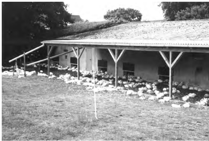
Abb. 2-9: Nutzungszonen im Grünauslauf des konventionellen Broilermast-Betriebes A3 – vor dem Wintergarten Zone 2 mit teilweise zerstörter Grasnarbe und mittlerer Nutzung, vorne links Zone 3 mit intakter Grasnarbe und geringer Nutzung
